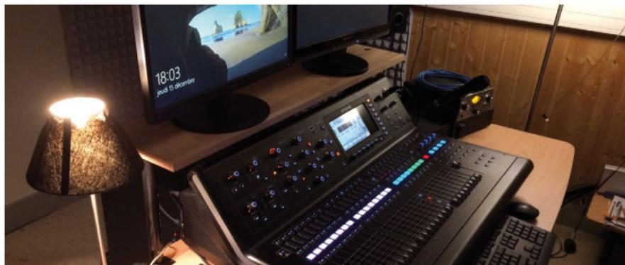
La régie d'enregistrement de la Filature fait 19 m<sup>2</sup> et est traitée acoustiquement. **Elle est reliée par multipaires aux 3 studios de répétition**, ce qui permet aux groupes d'enregistrer en condition live. Elle est équipée d'une console numérique Midas M32.
